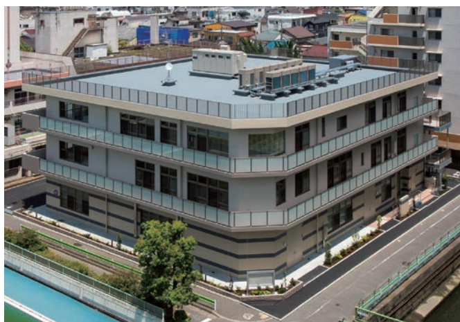
▲東京都大田福祉工場 (2018年6月竣工)
