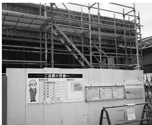
（仮称）中野5丁目障害者多機能型通所施設 建築の様子
