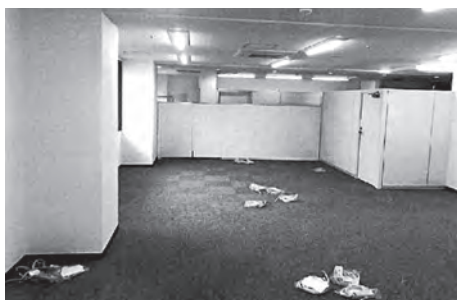
入居のための改修が完了したところ
