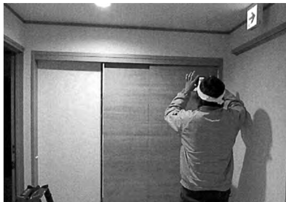
脱衣室のドアを修繕する様子
