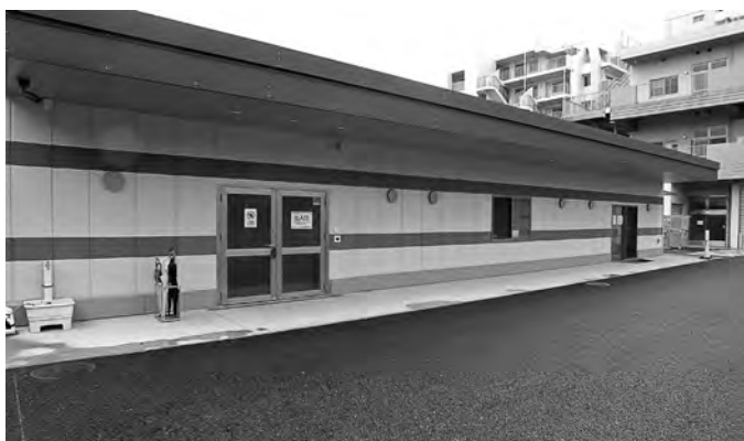
デジタル棟全景
